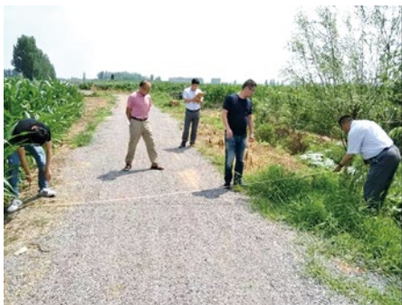
第三方在验收莱西市夏格庄镇温家泊村道路砂石化项目
