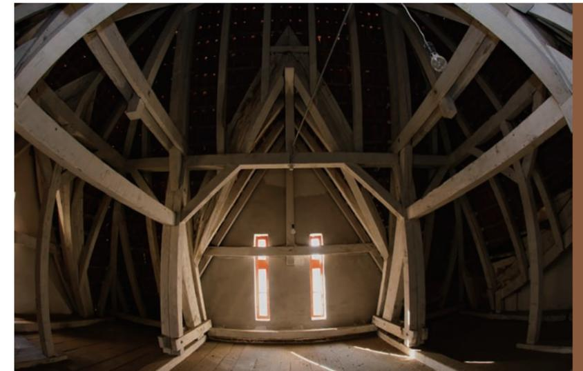
塔樓上的木結構屋頂，光線從木條的縫隙中投射下來，具有良好的通風、透光效果。
