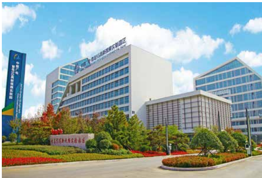
中国广电·青岛 5G 高新视频实验园区外景。（图片提供 / 青岛西海岸发展集团） Exterior of NRTA-Qingdao 5G High and New-Tech Video Pilot Park.
