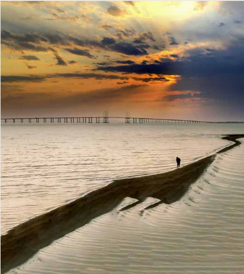
青岛胶州湾跨海大桥。（图/曹永华） Jiaozhou Bay Bridge.
