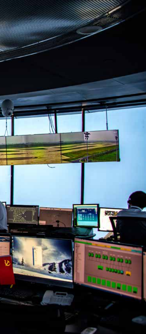
青岛胶东国际机场空管塔台中心区。(图 / 吕建军) The central district of ATCT in Qingdao Jiaodong International Airport.
