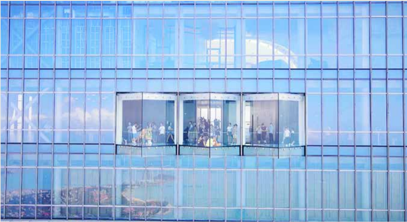
海天中心城市观光厅打造了全国首个悬挑式全景玻璃观光平台——钻石角。 Qingdao Haitian Center sightseeing hall build China's first cantilevered panoramic glass sightseeing platform, glass boxes.
