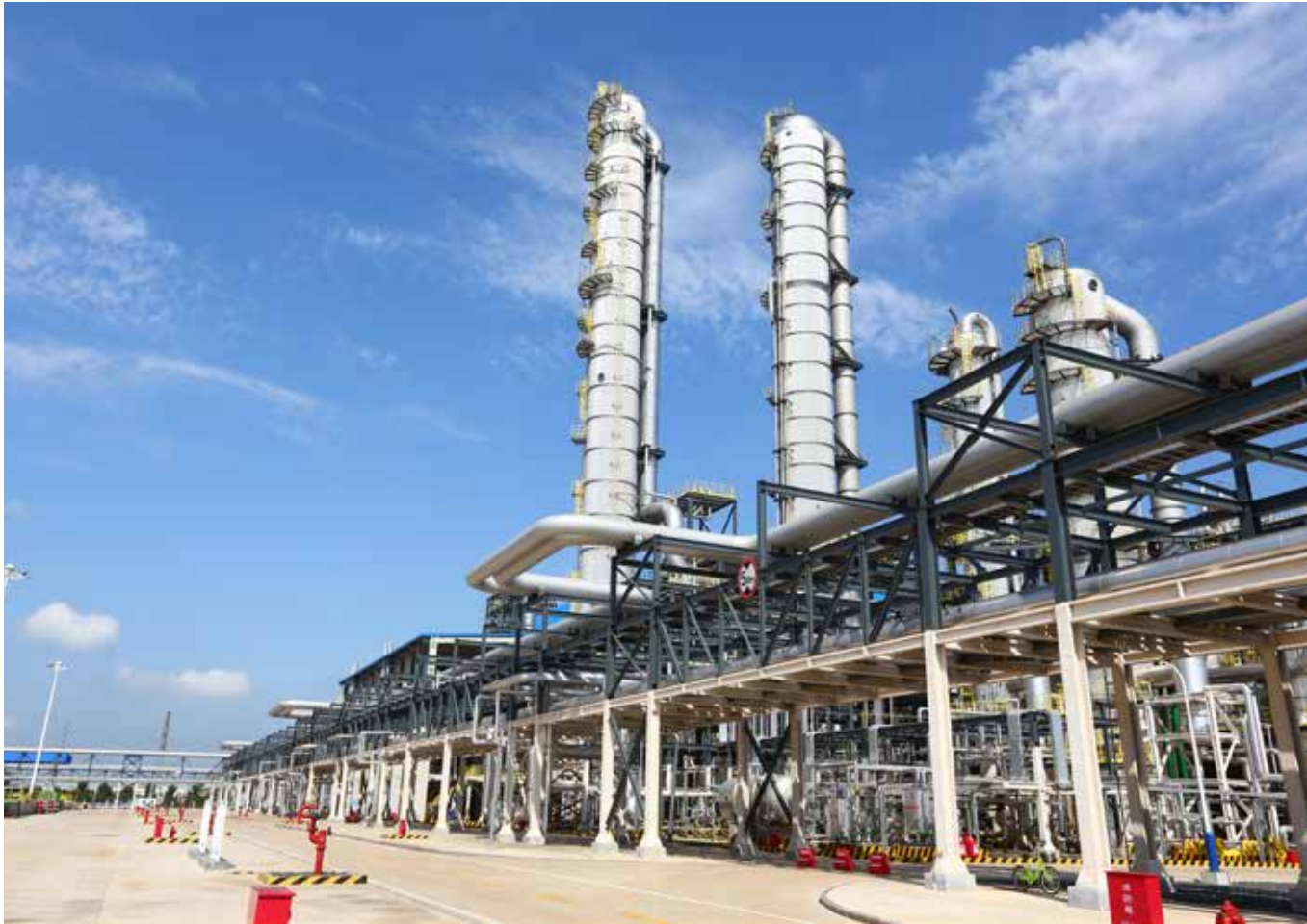
海湾化学装置区。 Haiwan Chemical Plant Area.
