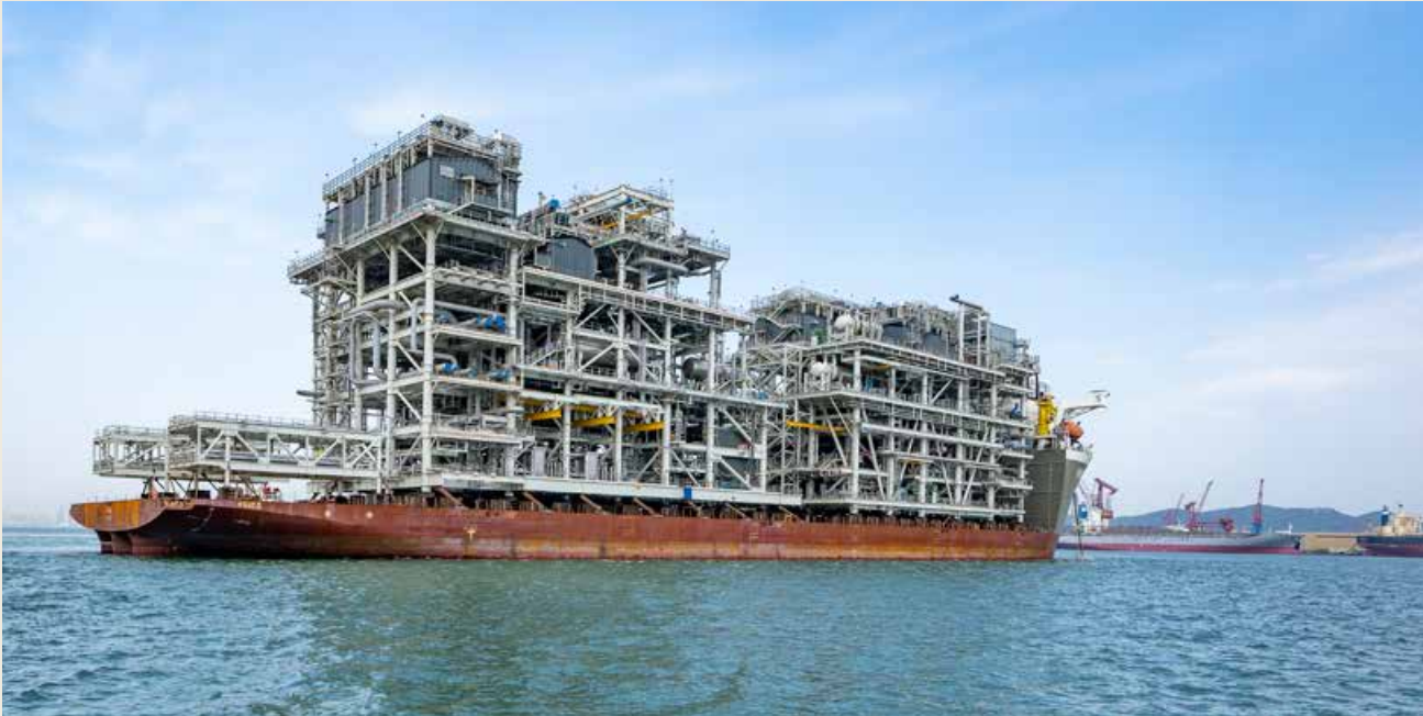
全球首批一体化建造 LNG 核心工艺模块在青岛西海岸新区顺利交付，标志着中国 LNG 模块建造能力已经稳居国际“第一梯队”，并在一体化建造等 LNG 模块化工厂前沿建造技术能力方面走在国际前列。（图片提供 / 中共青岛西海岸新区工委宣传部）
